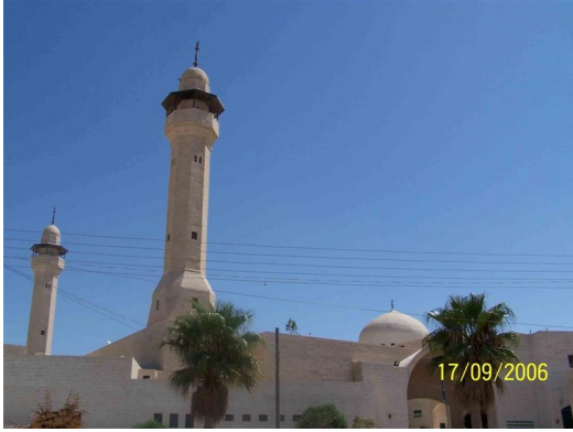
مسجد جعفر الطيار - المزار الجنوبي
